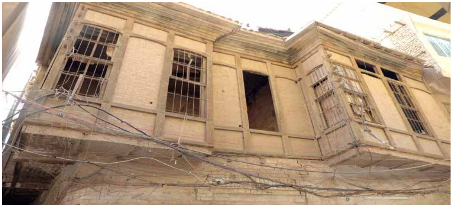
متى تنتهي عشوائية نقل الطاقة الكهربائية؟
